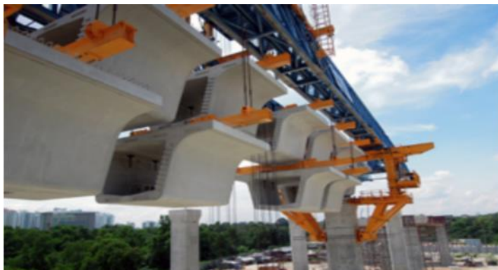
50 pav. Tarpatraminio tilto konstrukcijos etapas
