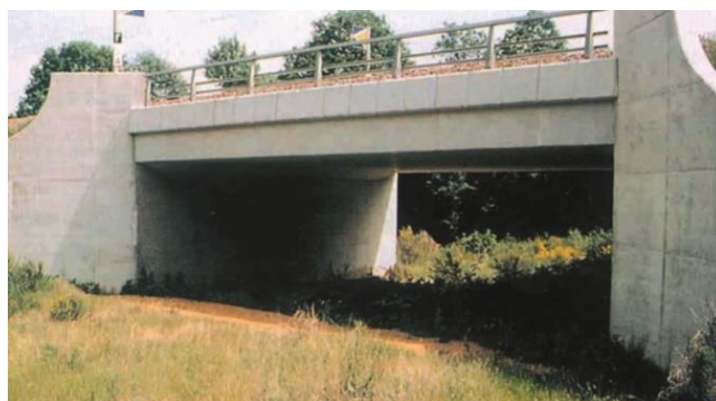
70 pav. Požeminė perėja gyvūnams po geležinkelio iš vietoje išliejamos betoninės struktūros
