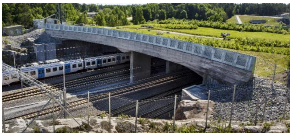
72 pav. Žaliasis tiltas iš vietoje išliejamos betoninės struktūros
