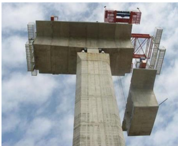
49 pav. Balansuotosios gembės surenkamosios statybos etapas
