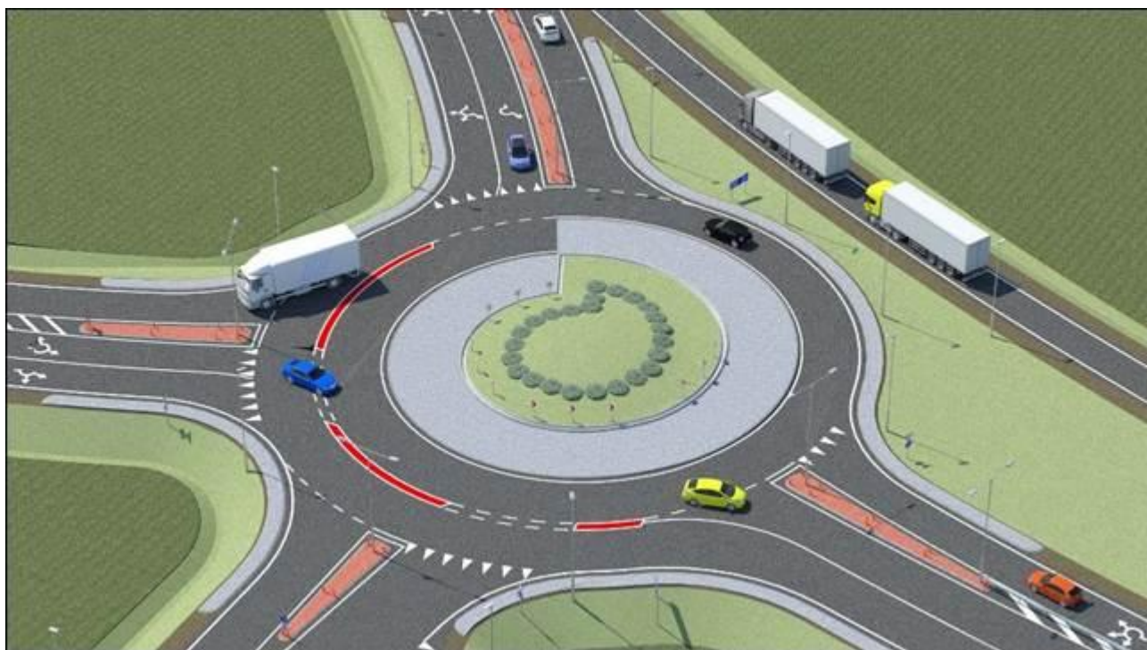
1-7 pav. Esama kelio A10 turbožiedinė sankryža su keliu A17 (AB „Panevėžio keliai“ vizualizacija)
