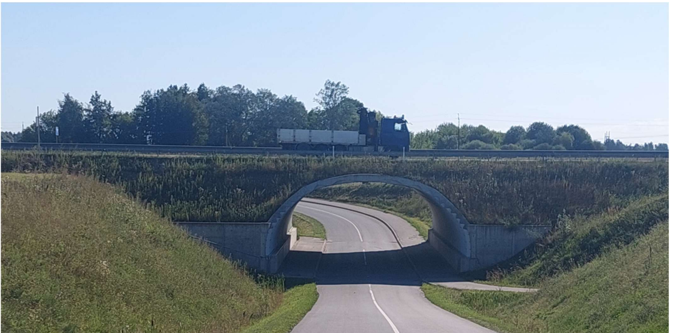
7 pav. Tunelinio automobilių viaduko (9,04 km) fasadai
