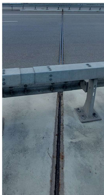
Deformacinės siūlės tvarkingos.
