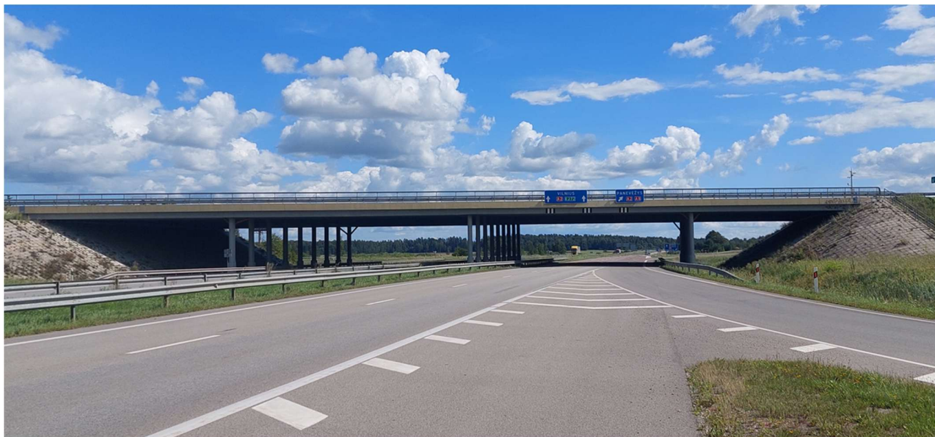
2 pav. Automobilių viaduko (7,508 km) fasadai
