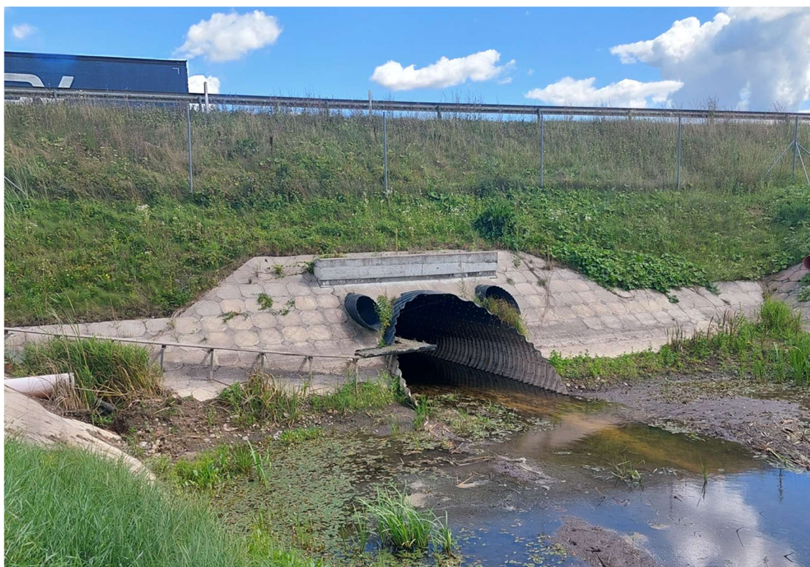
5 pav. Pralaidos su parėjimu varliagyviams (8,851 km) ištekėjimo antgalio vaizdas
