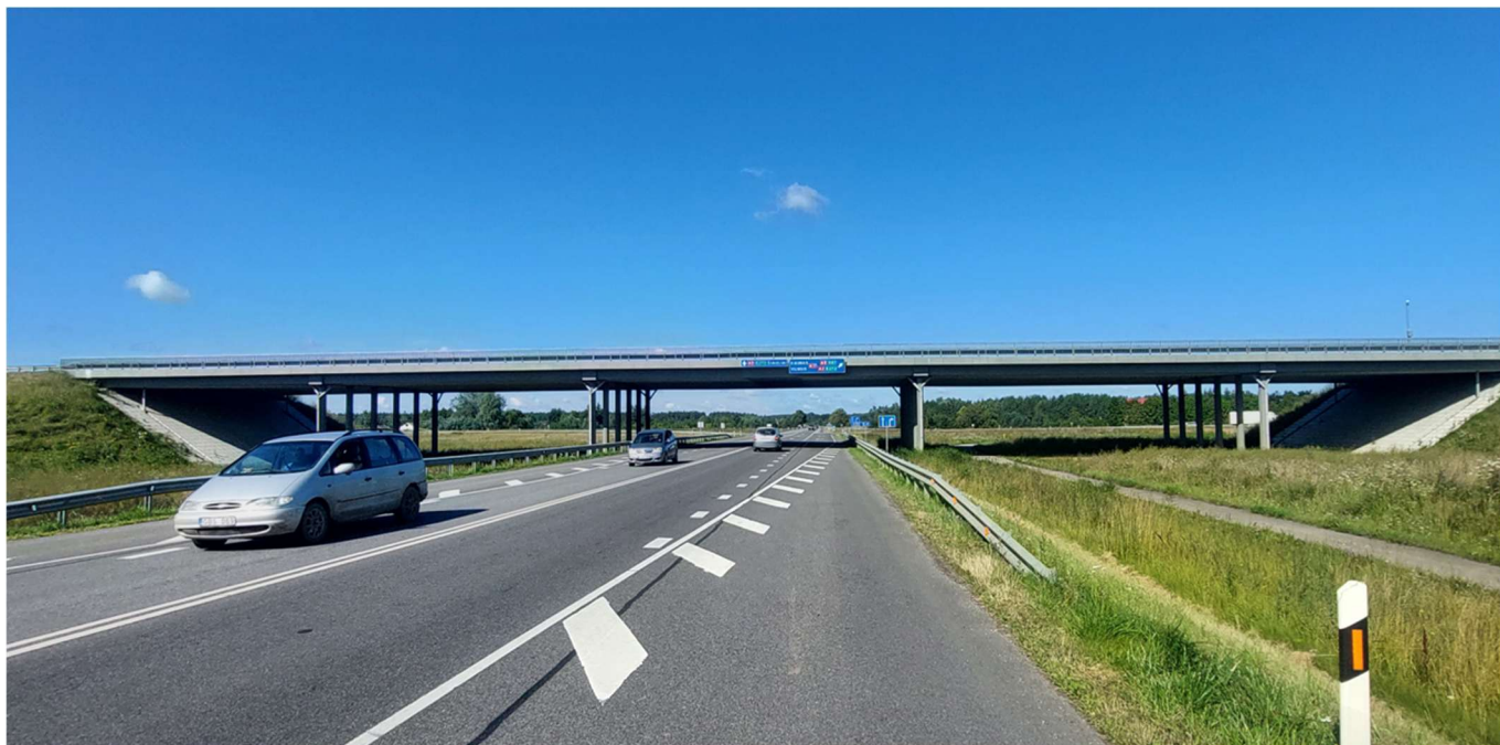
11 pav. Automobilių viaduko (11,015 km) fasadai
