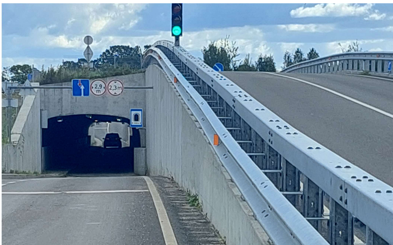
26 pav. Tunelinio automobilių viaduko (19,61 km) fasadai
