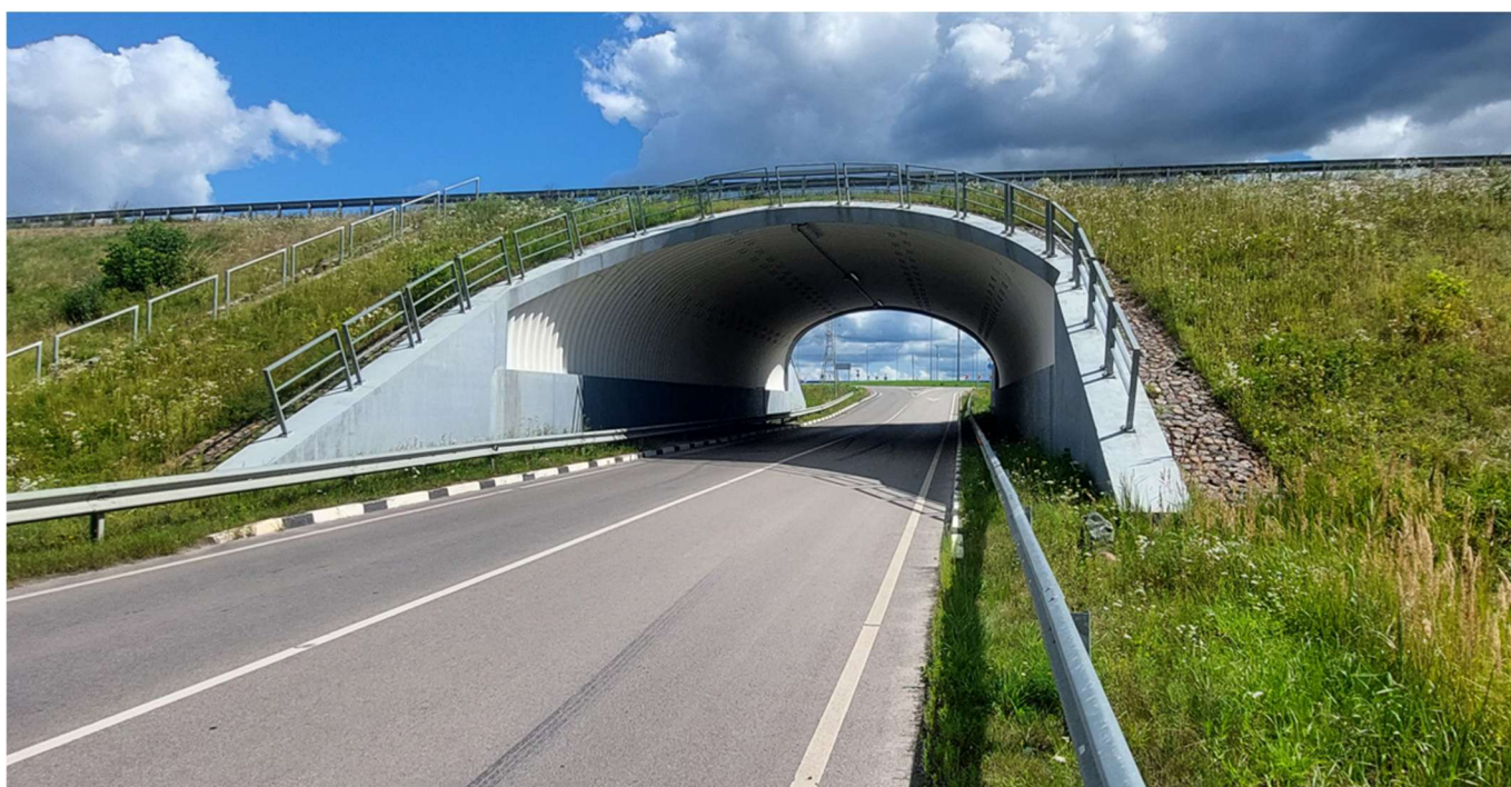
15 pav. Tunelinio automobilių viaduko (12,12 km) fasadai
