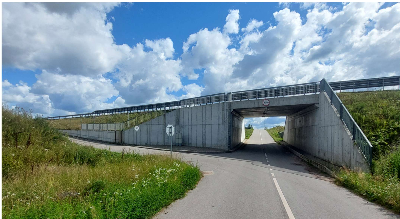
22 pav. Tunelinio automobilių viaduko (16,15 km) fasadai
