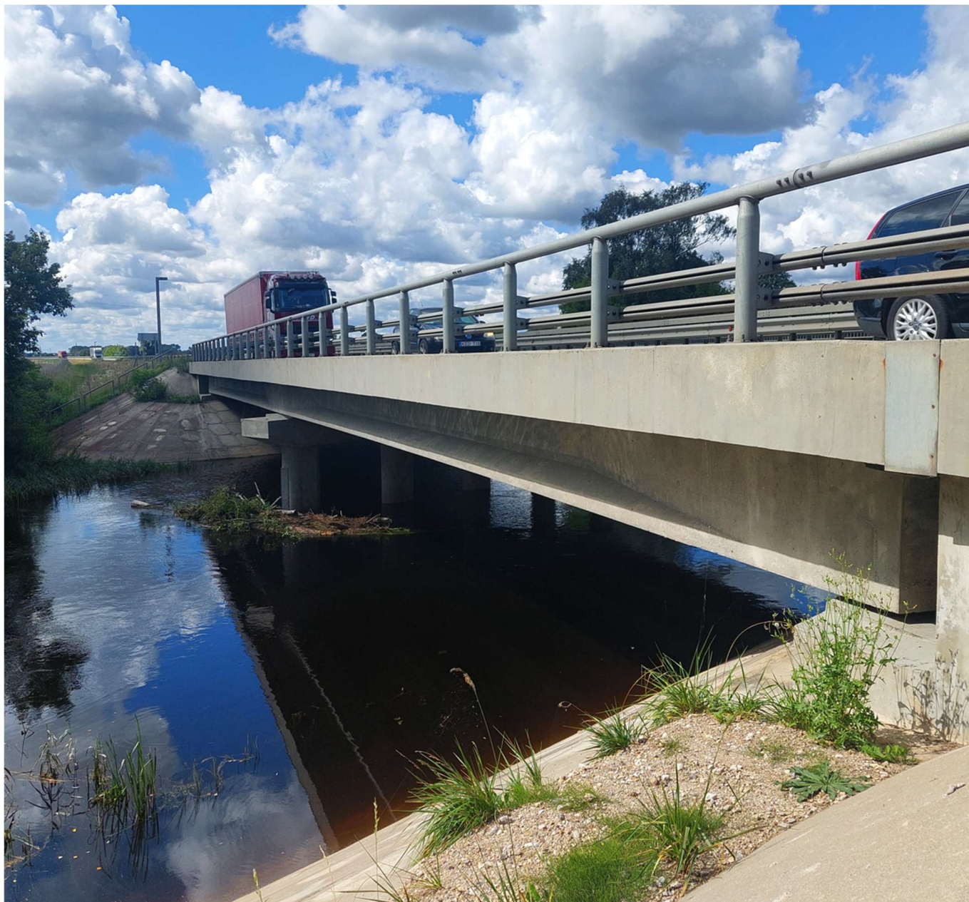
24 pav. Tilto per Lėvenį (19,225 km) fasadas
