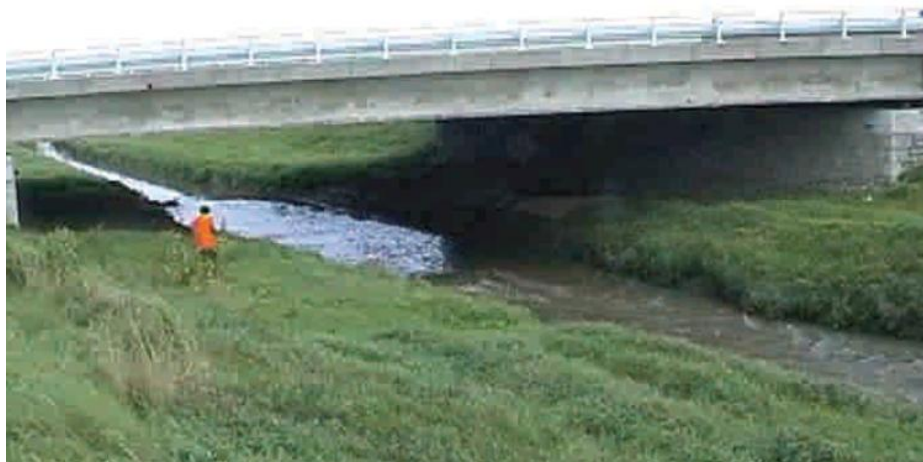
19 pav. Tiltas per upę paliekant vietas gyvūnų migracijai krantu (gyvūnų perėja po tiltu)
