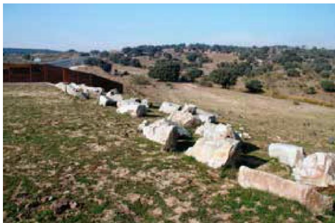
16 pav. Sistemos, kuriose naudojami rieduliai, kad būtų išvengta transporto priemonių judėjimo gyvūnams skirtuose statiniuose (perėjos, žalieji tiltai)
