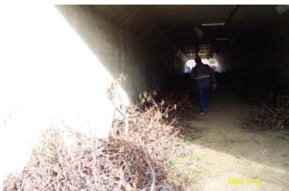
14 pav. Sausų šakų, šaknų, rastų, akmenų ar kitų natūralių objektų išdėstymas perėjose suteikia slėptuves gyvūnams (Potenciano et al. 2016)
