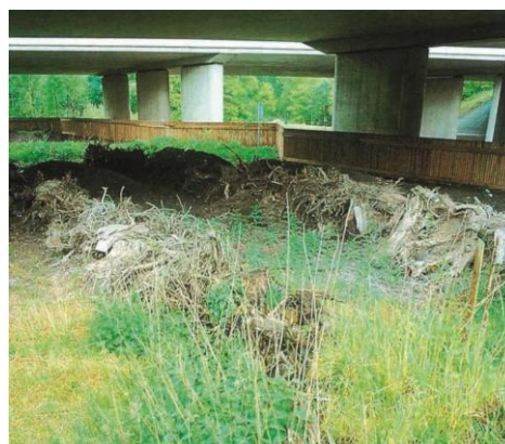
14 pav. Sausų šakų, šaknų, rastų, akmenų ar kitų natūralių objektų išdėstymas perėjose suteikia slėptuves gyvūnams (Potenciano et al. 2016)
