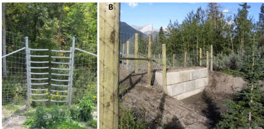
13 pav. Gyvūnų pabėgimo įrenginiai: A – vienvėriai varteliai, B – nušokimo rampa
