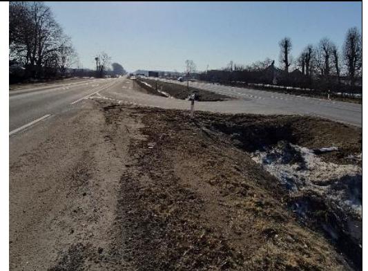
54 pav. Valstybinės reikšmės krašto kelio Nr. 141 Kaunas – Jurbarkas – Šilutė – Klaipėda 221,89 km esantis apsisukimas iš dešinės kelio pusės į kairę pusę per skiriamąją juostą žiūrint Šilutės kryptimi (be išplatinimo)
