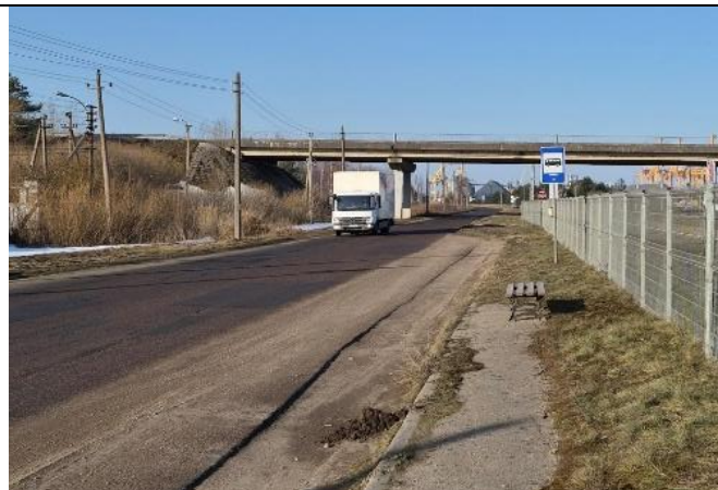
13 pav. Kairių g. autobusų stotelė „Kairių“ žiūrint Taikos pr. kryptimi (be įvažų ir perono)
