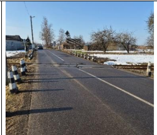
28 pav. Gručeikių gatvės ir geležinkelio kelio Klaipėda – Pagėgiai vieno lygio pervaža link Vytauto Pauliaus g. (Gručeikių gatvės danga – patenkinamos būklės asfaltas)
