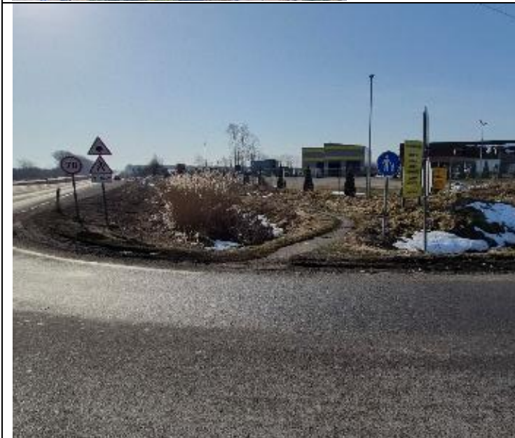
65 pav. Pėsčiųjų takas nuo Gručeikių gatvės iki 221,68 km esančios autobusų sustojimo aikštelės
