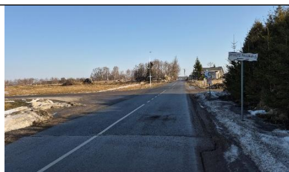
24 pav. Sankryža iš Gručeikių g. į Vytauto Pauliaus g. (gatvių danga asfaltas)
