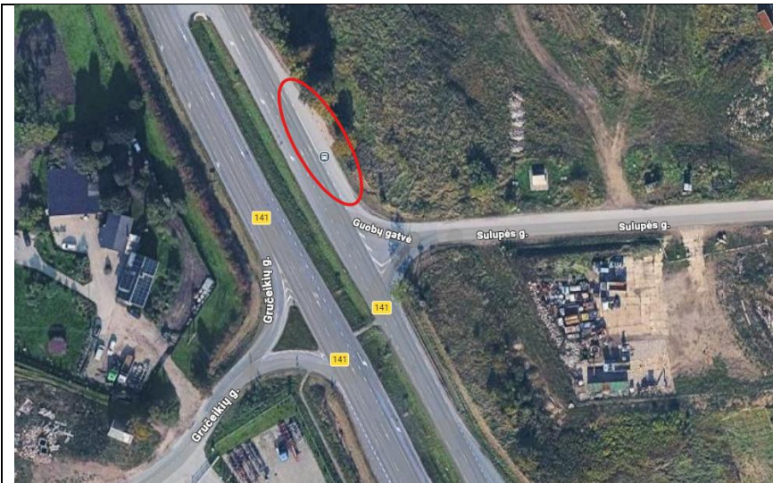
57 pav. Valstybinės reikšmės krašto kelio Nr. 141 Kaunas – Jurbarkas – Šilutė – Klaipėda (dešinė pusė) 221,84 km esančios autobusų sustojimo aikštelės „Dumpiai“ planinė padėtis
