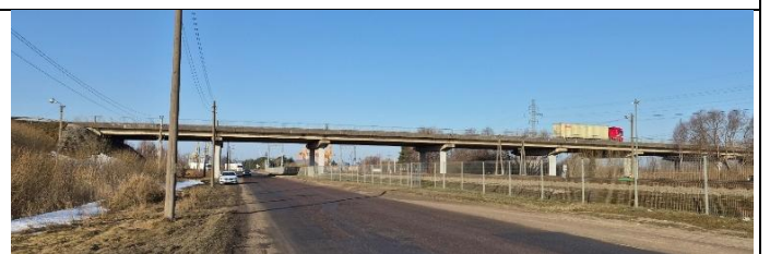
3 pav. Viaduko (Taikos pr.) fasadas (dešinė pusė žiūrint Kuršių Marių kryptimi)
