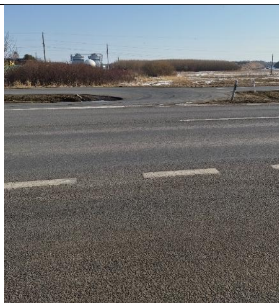
47 pav. Valstybinės reikšmės krašto kelio Nr. 141 Kaunas – Jurbarkas – Šilutė – Klaipėda 221,70 km esantis apsisukimas iš kairės kelio pusės į dešinę pusę per skiriamąją juostą (su išplatinimu)
