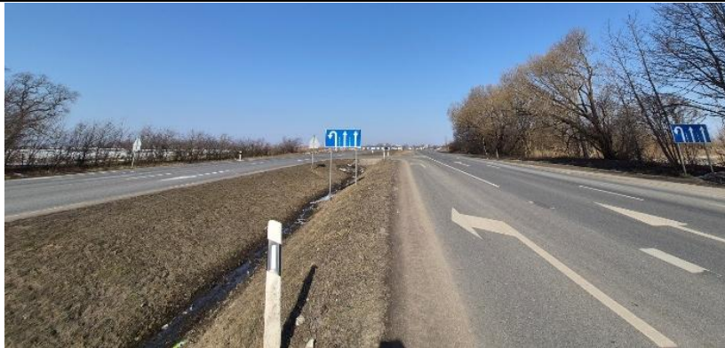
53 pav. Valstybinės reikšmės krašto kelio Nr. 141 Kaunas – Jurbarkas – Šilutė – Klaipėda 221,89 km esantis apsisukimas iš dešinės kelio pusės į kairę pusę per skiriamąją juostą žiūrint Klaipėdos kryptimi (su lėtėjimo juosta)
