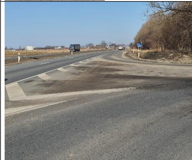
44 pav. Ketvergių g. sankryža su krašto kelio Nr. 141 (žiūrint nuo krašto kelio Nr. 141 Klaipėdos kryptimi) su greitėjimo juosta
