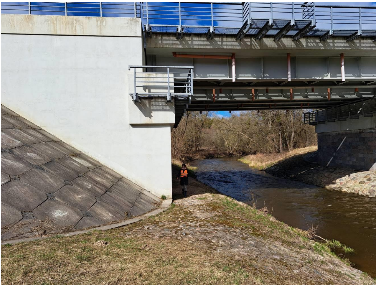
58 pav. Po tiltais palikta erdvė pramigruoti įvairaus dydžio gyvūnams
