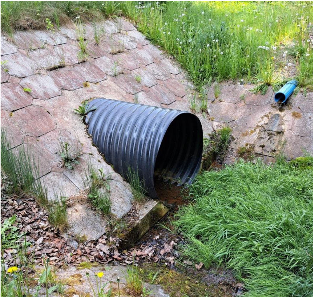
69 pav. Nepritaikyta migracijai pralaida Nr. 6, esanti Jiesios kraštovaizdžio draustinyje, „Natura 2000“ teritorijoje
