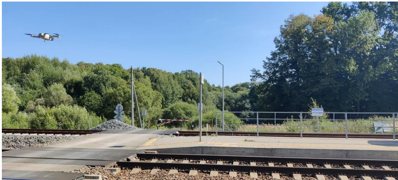
36 pav. Esama geležinkelio pervažą Jiesios g., vietoj kurios planuojamas automobilių tunelis (40 pav. pažymėta 1 Nr.)
