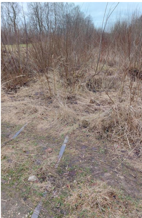
Pav. 98. Siaurojo geležinkelio komplekso esama būklė ties planuojama Joniškėlio stotimi
